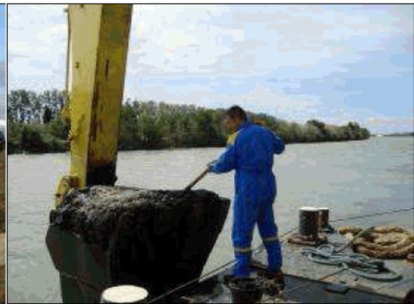
Figure 77 –Pelle sur ponton.
